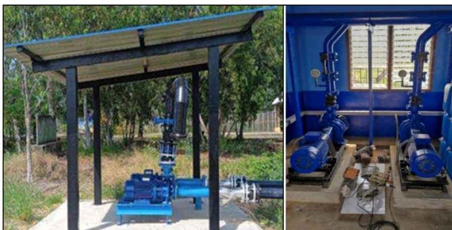
ภาพที่ ๑๐ ภาพระบบสูบน้ำดิบ (Raw Water Pump)
