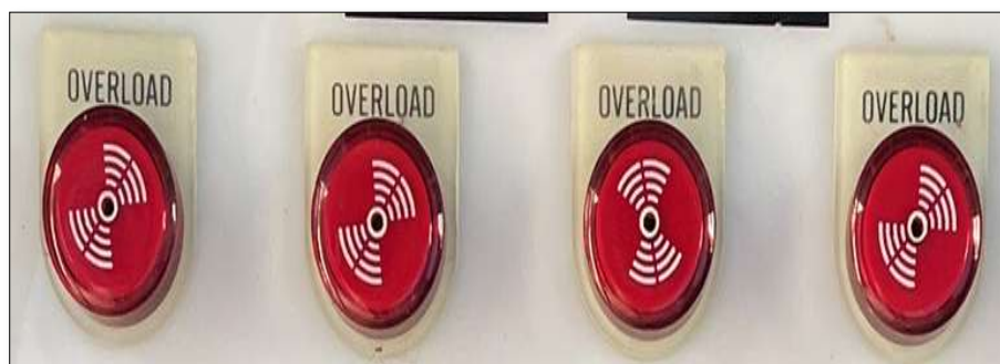
ภาพที่ ๑๓ ไฟแสดงสถานะ โอเวอร์โหลด (Over Load Relay)
