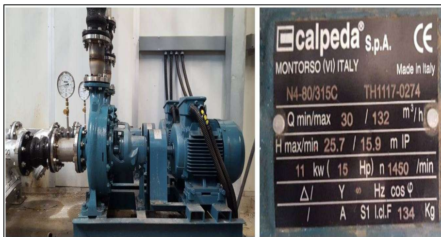
ภาพที่ ๓๘ Name Plate ของปั้มน้ำ Calpeda รุ่น N๔ ๘๐/๓๑๕ C
