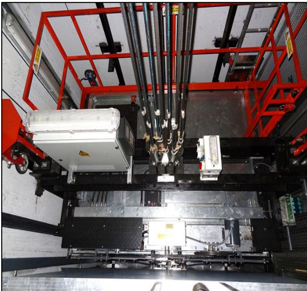
ภาพที่ ๗ ลิฟต์ที่เป็นระบบสลิง
