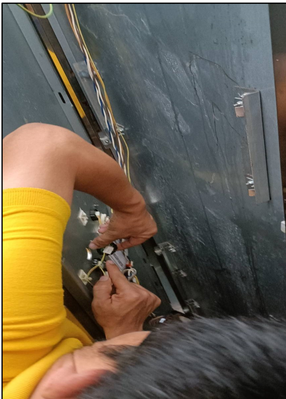
ภาพที่ ๒๕ ภาพซ่อมปุ่มกดภายในห้องลิฟต์โดยสาร
