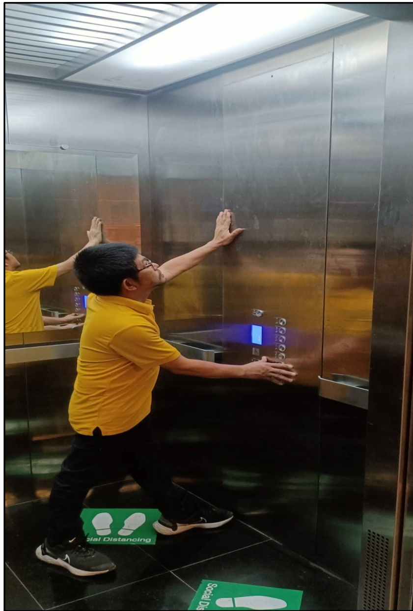
ภาพที่ ๒๖ ภาพยึดปิดฝา COP ด้านบน-ล่าง ภายในห้องโดยสารลิฟต์
