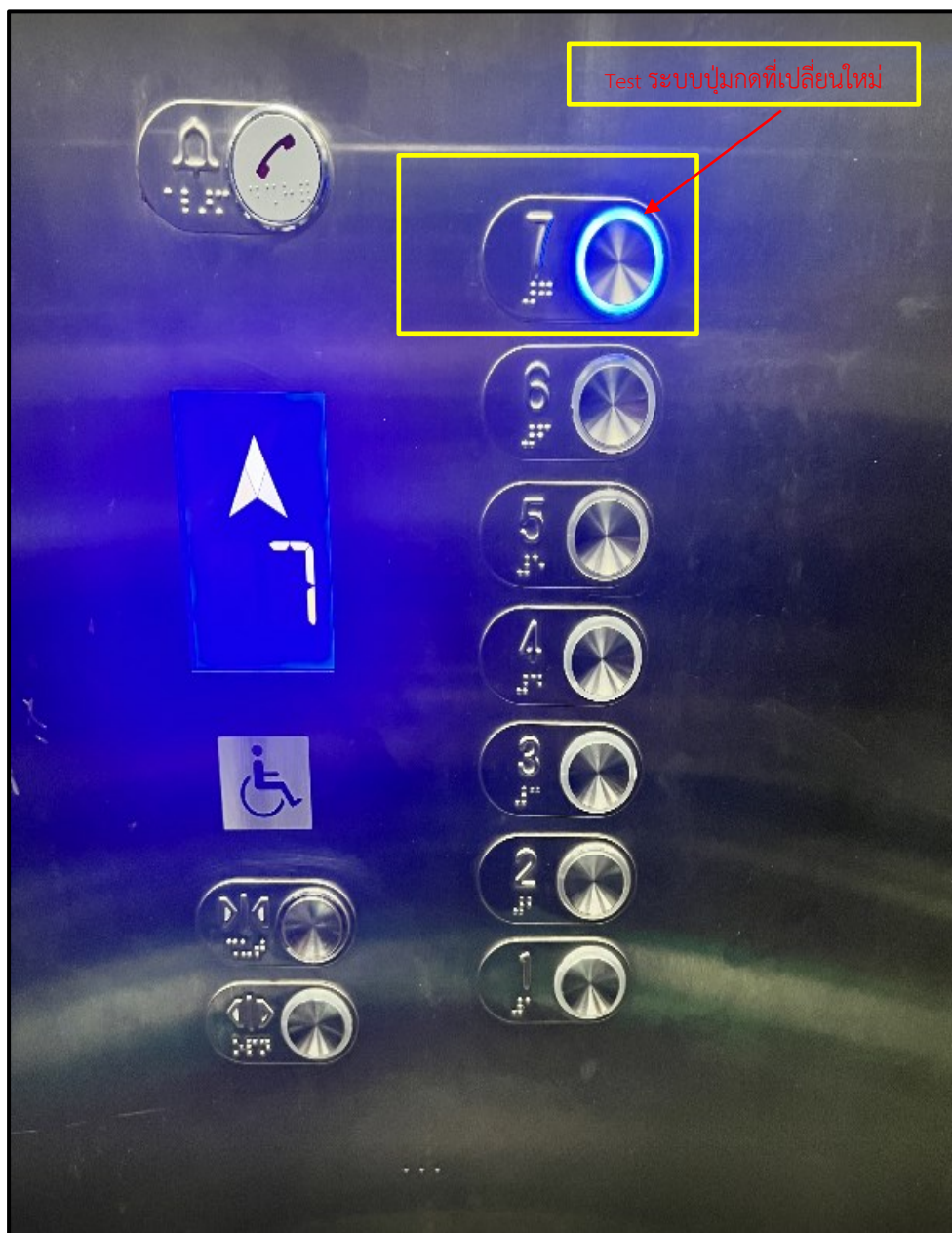
ภาพที่ ๒๙ ภาพ Test ระบบปุ่มกดที่เปลี่ยนใหม่
