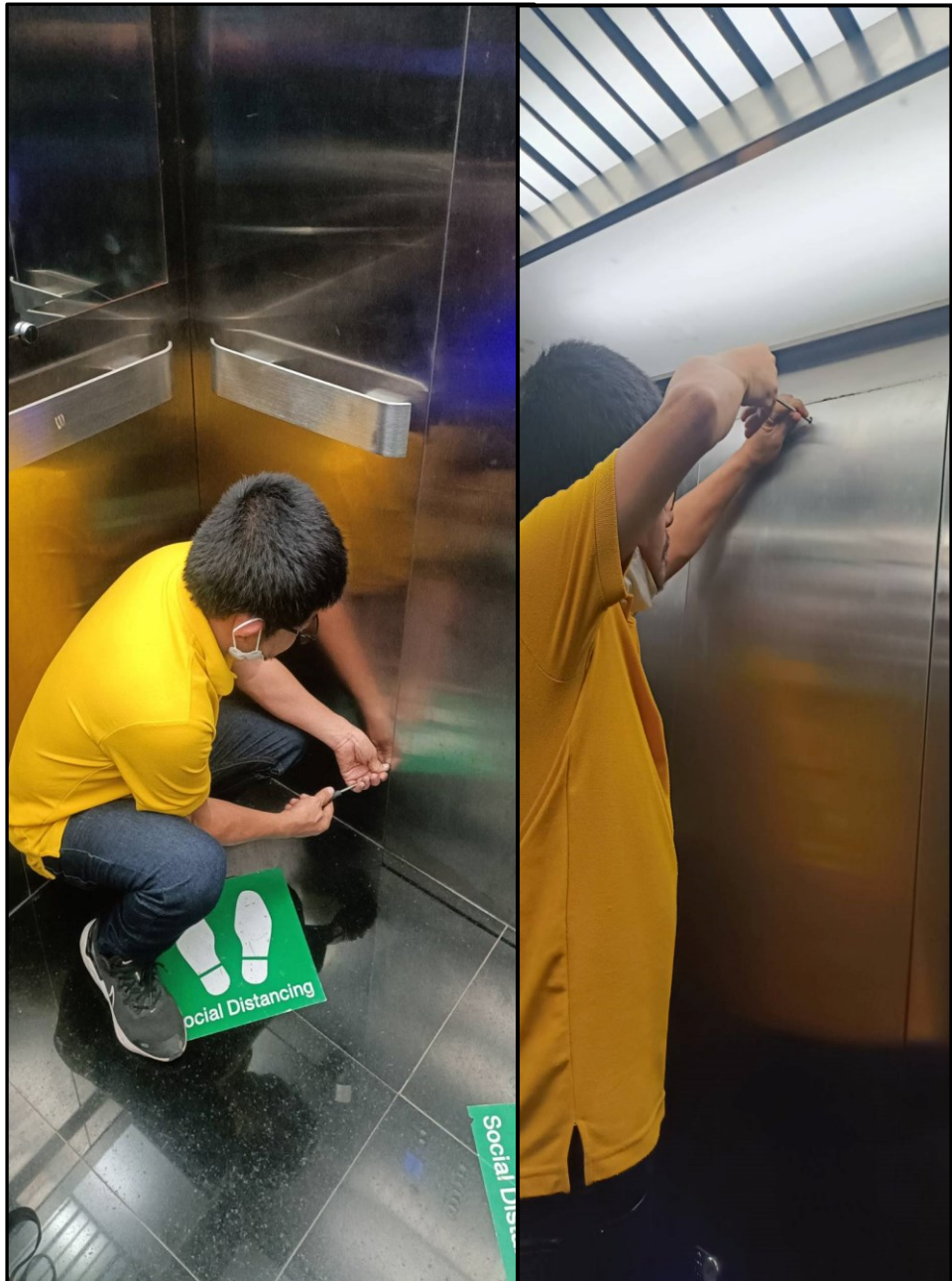
ภาพที่ ๑๙ ภาพการขันน็อตยึดฝา COP ด้านบน-ล่าง ภายในห้องโดยสารลิฟต์ออก
