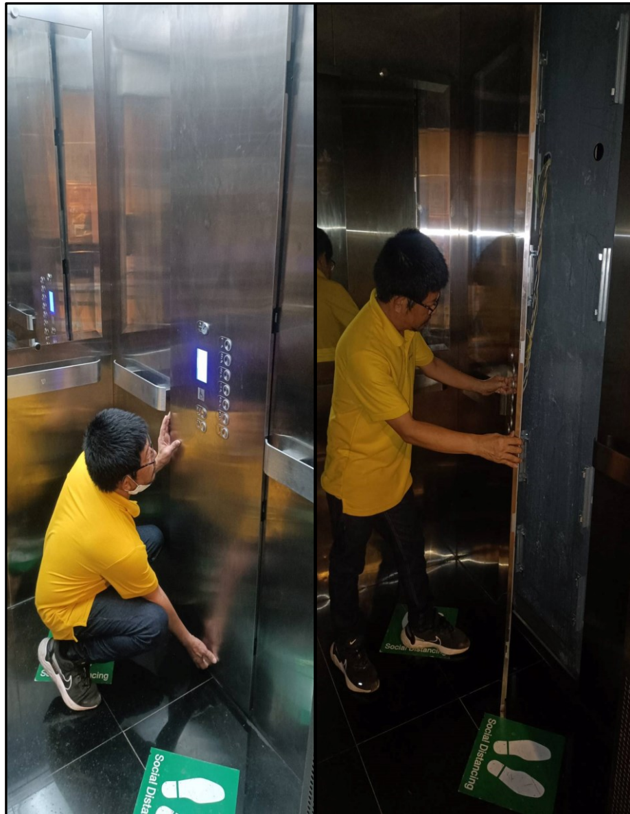
ภาพที่ ๒๐ ภาพการยกเปิดฝา COP ด้านบน-ล่าง ภายในห้องโดยสารลิฟต์ออก
