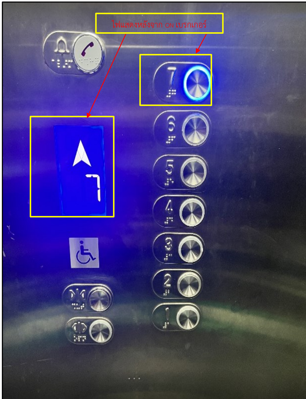
ภาพที่ ๒๘ ภาพปุ่มกดลิฟต์หลังจาก ON เบรกเกอร์
