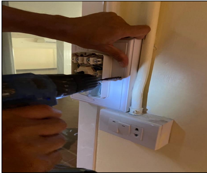
ภาพที่ 3.54 การยึดสกรูฝาหลัง
