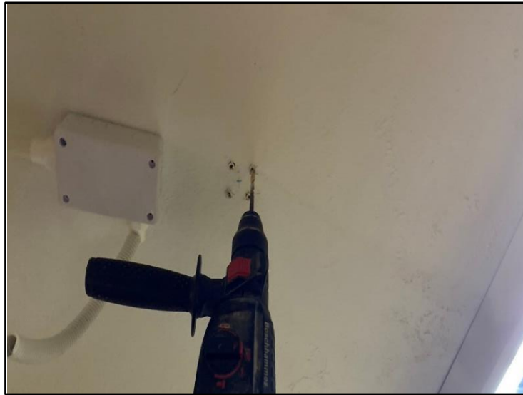
ภาพที่ 3.43 การกำหนดจุดเจาะฐานยึดพัดลม
