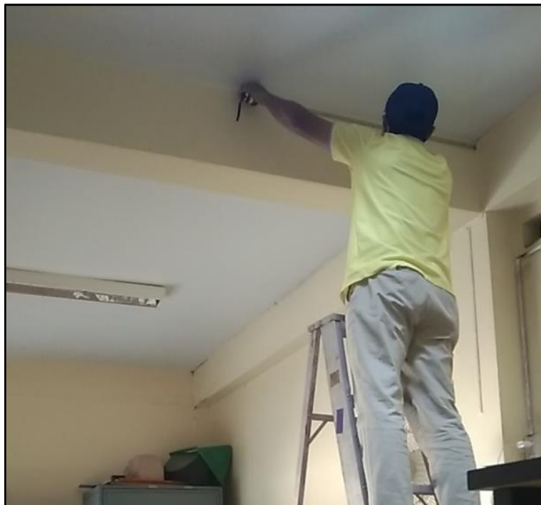
ภาพที่ 3.35 การวัดระยะความยาวรวมของท่อร้อยสาย
