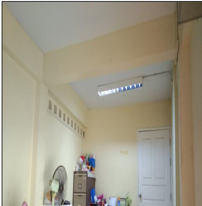
ภาพที่ 3.6 ภาพมุมกว้างจากการเข้าสำรวจหน้างานเพื่อการติดตั้งพัดลมโคจร
