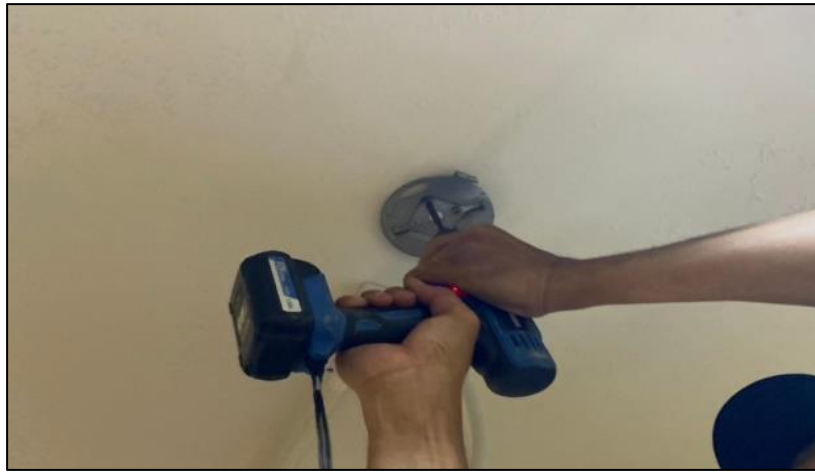
ภาพที่ 3.44 การติดตั้งฐานยึดพัดลม
