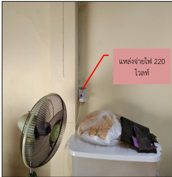
ภาพที่ 3.7 ภาพมุมแคบจากการเข้าสำรวจหน้างานเพื่อการติดตั้งพัดลมโคจร
